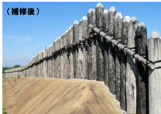
<防腐処理材による木柵の補修>
