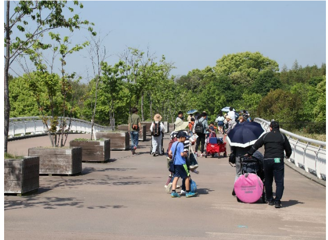
天の浮橋（あまのうきはし）
