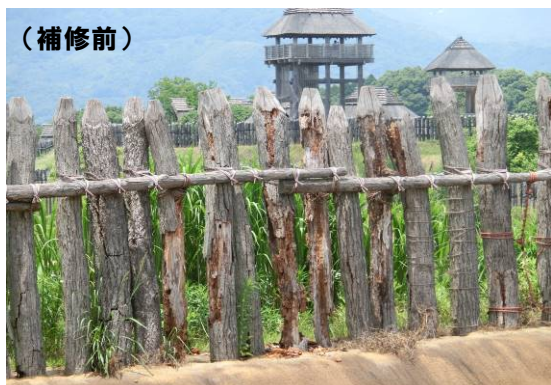
<防腐処理材による木柵の補修>
