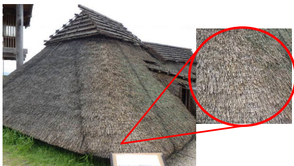
〈ヨシの抜落ち対策(飛散防止等網掛け)〉
