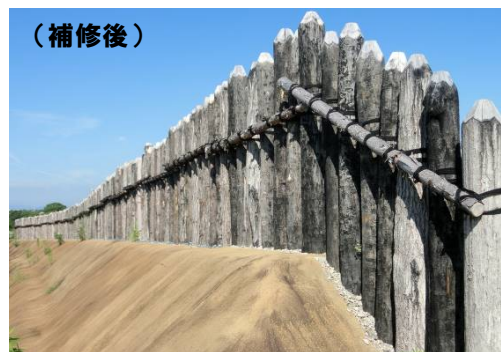
<防腐処理材による木柵の補修>
