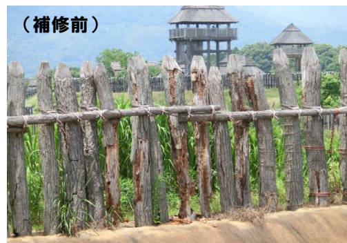
<防腐処理材による木柵の補修>
