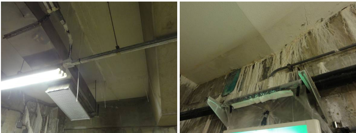
図 1-3 階下の漏水
