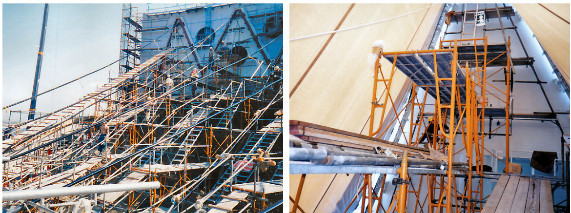
図 1-5 I 期工事・膜架設の様子
