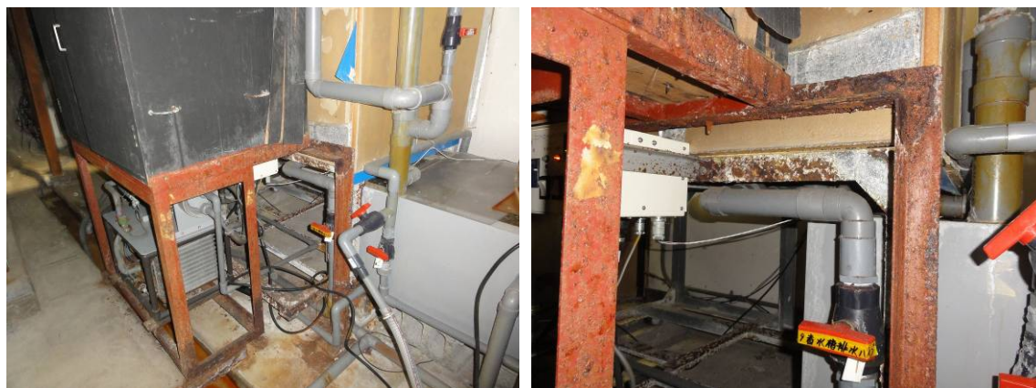
図 1-6 展示水槽架台部分
