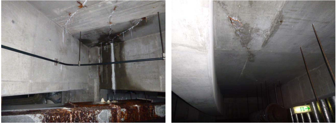
図 1-4 大水槽下部の漏水
