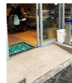
スロープの設置
