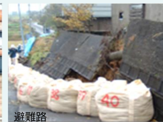
擁壁の防災対策
