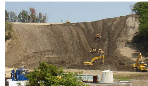
盛土撤去工事のイメージ
