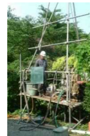
安全性把握調査 (ボーリング調査)
