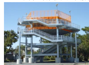
津波避難タワー
