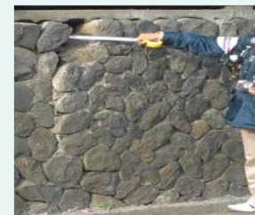
擁壁の危険度調査
