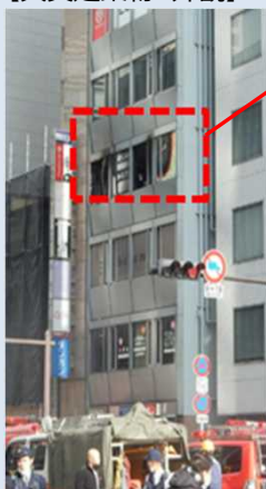
【火災建築物 外観】
