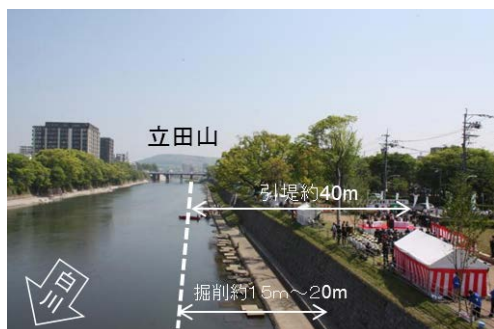
写真－1 完成した緑の区間
