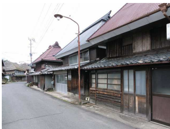
写真3 法的には不燃化されている茅葺屋根
