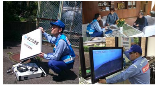
写真11 村長室での打合せ及び通信設備設置状況
