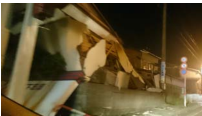
写真7 建物の被災状況(本震直後)
