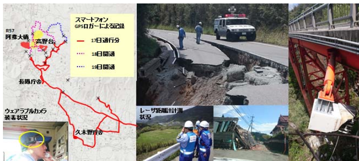
写真12 GPSロガーで記録した走行記録と道路被災状況（南阿蘇村）
