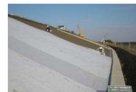
写真-4 遮水シート布設状況
