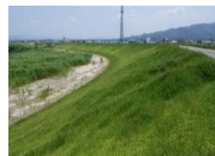
写真-6 堤防一枚法化
