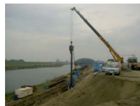
写真-2 矢板打設状況
