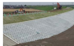
写真-5 護岸施工状況
