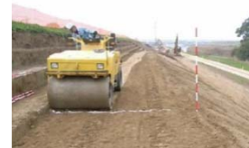
写真-3 断面拡大施工状況
