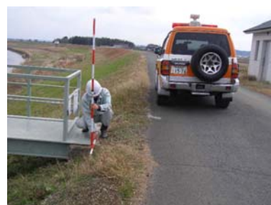
写真-6 平常時巡視
