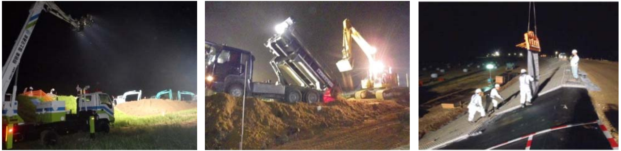
写真－3 災害用照明車稼働状況（左）、 夜間工事状況（中央、右）
