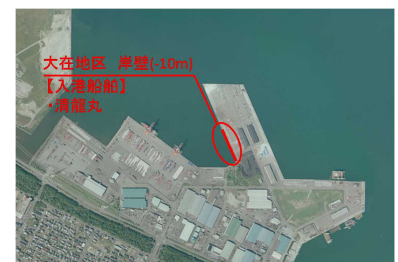
写真-2 大分港（大在地区）航空写真
