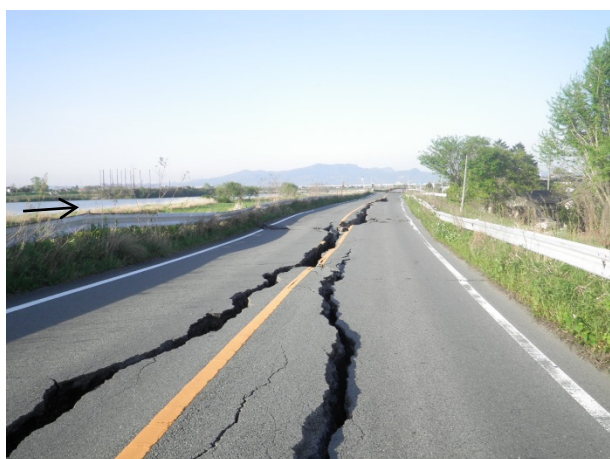
緑川 右岸 8k 800 被災状況
