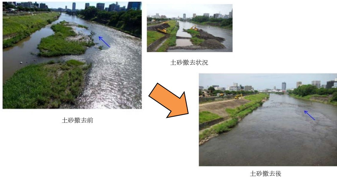
図－8 代継橋下流の堆積土砂撤去状況
