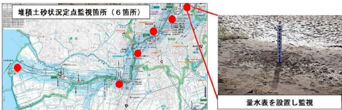
図-7 白川 堆積土砂の監視状況
