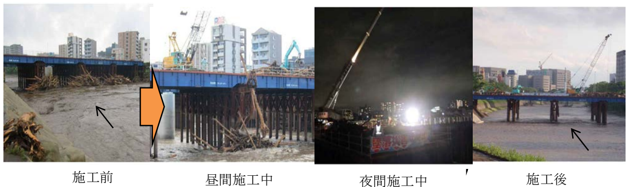
図－9 明午橋(仮橋)橋脚に堆積した流木撤去状況
