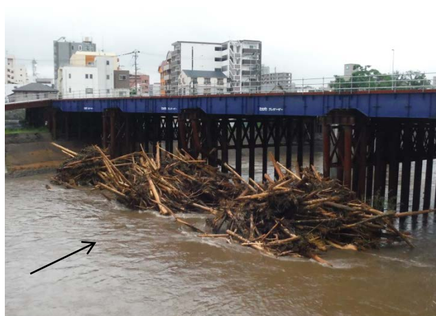
白川 明午橋(仮橋)橋脚の流木堆積状況
