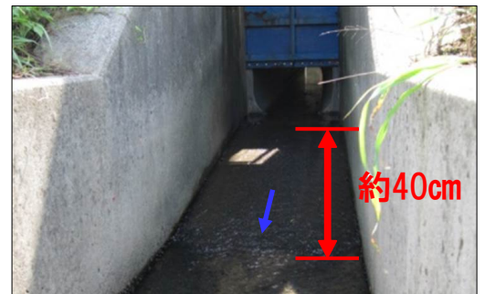
写真3 樋管底盤と川表水路【整備前】
