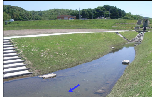
写真11 取付水路 完成後1ヶ月
