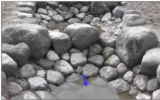
写真5 見直し前（石の表面を流れない）
