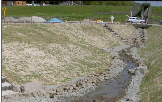
写真10 取付水路 施工状況
