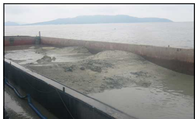
写真-3 土運船排水状況
