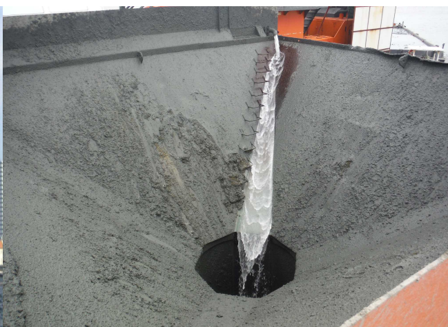
写真-5 2重管トレミー管投入口
