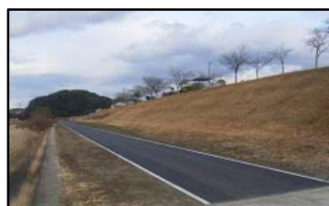
写真-5 整備した管理用通路
