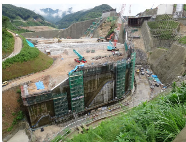
図 1.2 大分川ダムの工事状況
