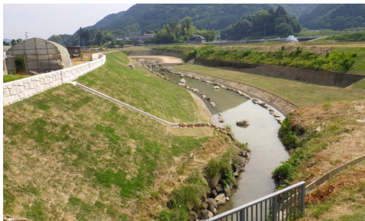
写真-6 整備後の駒鳴地区
