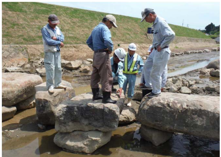
写真-5 飛び石設置間隔の現地確認の様子
