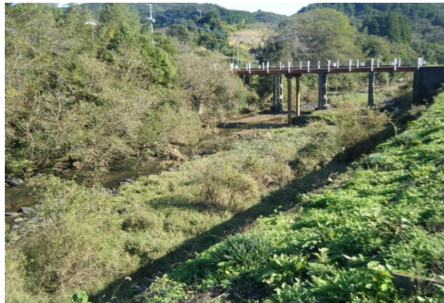
写真-1 松浦川駒鳴地区整備前
