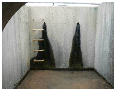
写真5 集水枡（管から望む）
