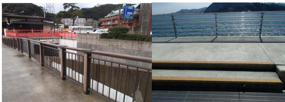
写真-3 転落防止柵の設置状況
