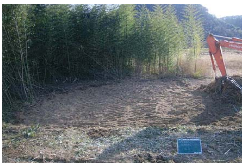
写真－2 伐採、抜根中
