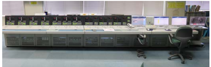
図6：新ダムコン操作卓
