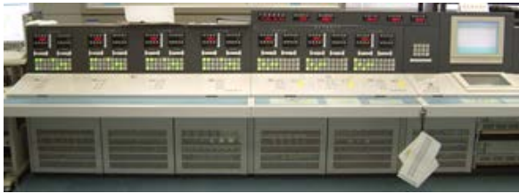
図5：旧ダムコン操作卓
