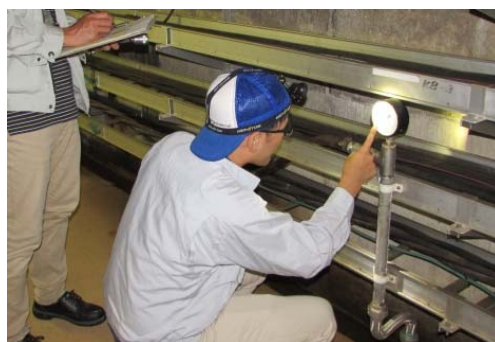
図 2 点検状況写真
