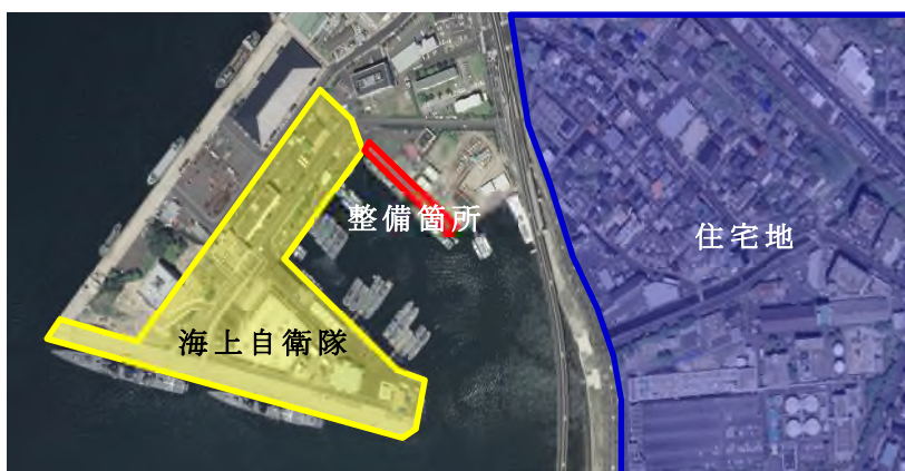
写真-4 整備箇所周辺状況
