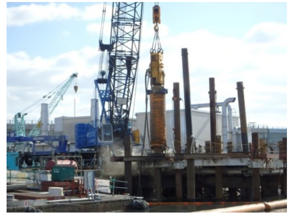
写真-5 鋼管杭打設状況写真 (ダウンサールハンマ工法)
