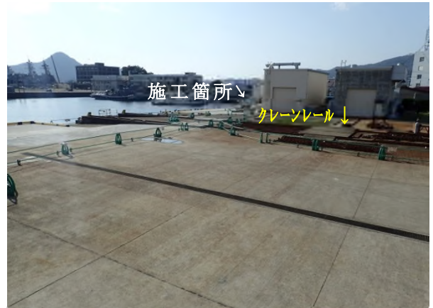
写真-10 クレーンレール養生状況(工事完成後)
