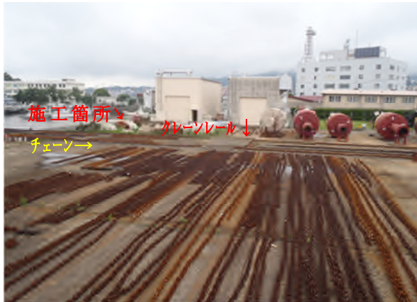
写真-9 クレーンレール養生状況(現地着手前)
