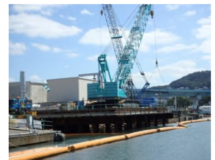
写真-7 仮設栈橋設置完了
