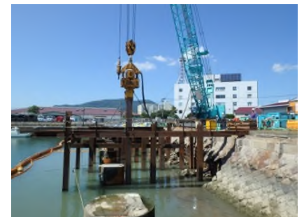
写真-6 仮設栈橋設置作業
