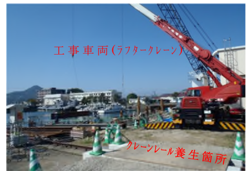
写真-11 クレーンレール養生状況 (⑦ブロック作業中)
