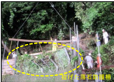
仮設防護柵設置状況①
