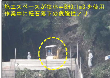
崩落土砂撤去状況
