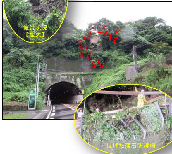
被災箇所【遠景】
