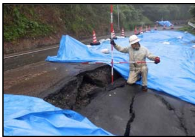
6月10日発生 南さつま市坊津町 大規模地すべり
