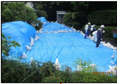
ブルーシート敷設状況
