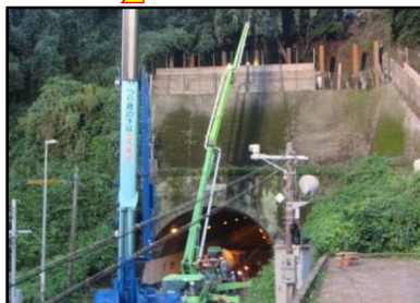
仮設防護柵設置状況②
