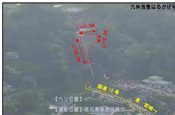
被災箇所【全景】
