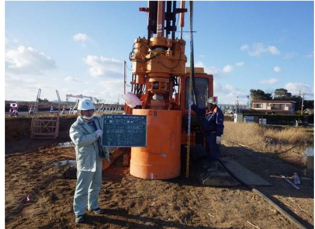
図-7 深層混合処理の施工状況
