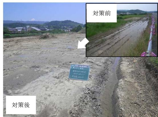
図-8 湧水対策の施工状況
