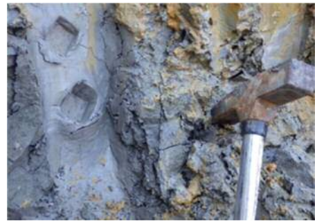
写真-2 トンネル脚部に出現した泥岩
