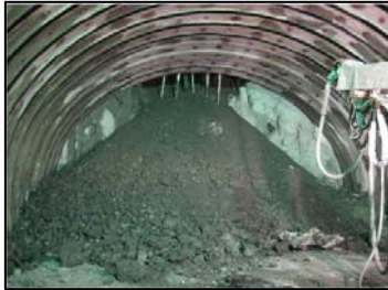
図-4. 切羽の崩壊
