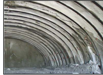
図-5. 吹付けコンクリートのひび割
