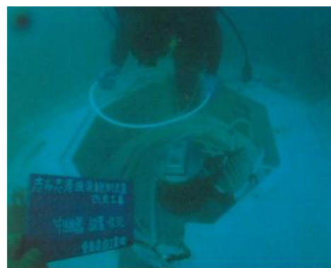
【写真-2：海底ケーブル埋設作業】
