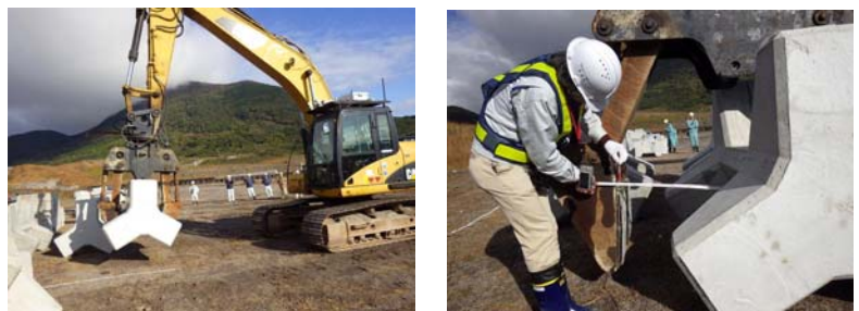
写真-4 平行式グラップル型把持装置の検証試験状況 (3連ブロック)
