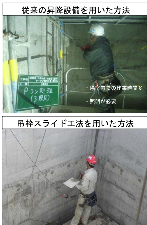
図-8 従来方法との作業状況比較
