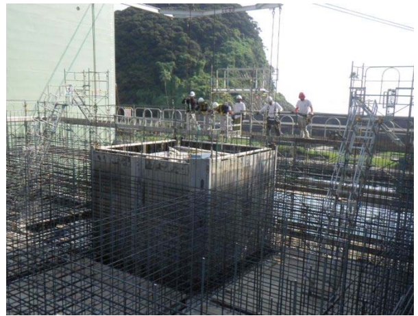
図-3 内型吊枠スライド状況
