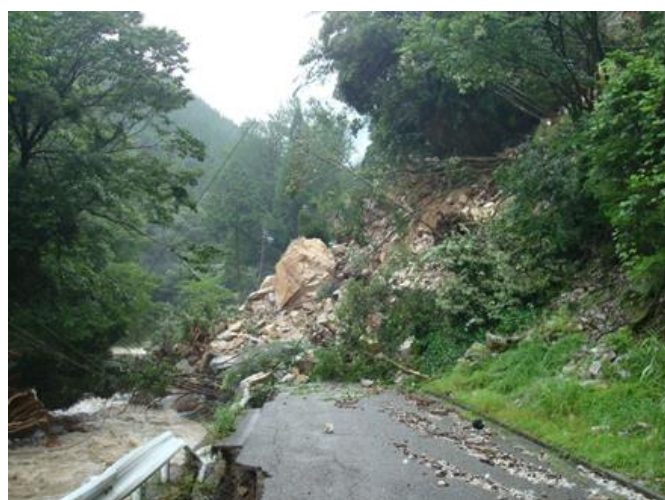
写真-2 平成24年7月豪雨の災害状況(村道入鴨線)
