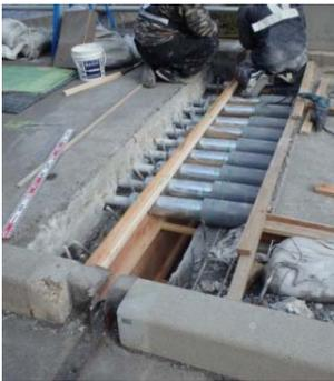
写真 情報管路の補修 (橋面部より)
