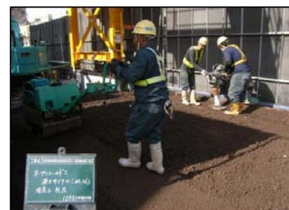
シールドジャッキにてオープンシールド機を推進し、推進函体と後方函体を緊結した後、新たに推進函体の据付けを行う。（写真-6、写真-7 参照）その後、設置済み函渠について埋戻し（写真-8 参照）を行い施工完了となる。
