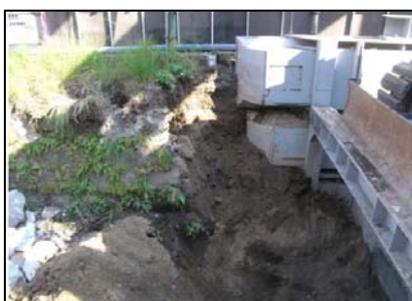
写真-7 推進函体据付け
