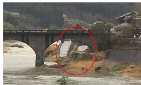
写真-4 坂路の張り出し
