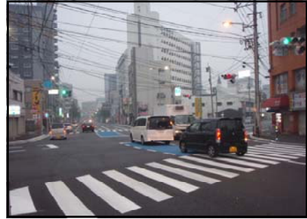
写真-3：右折レーン完成後
