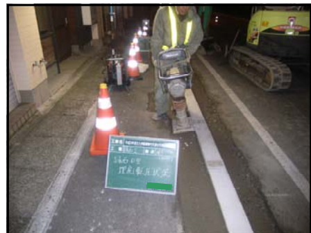
写真-6：夜間施工状況
