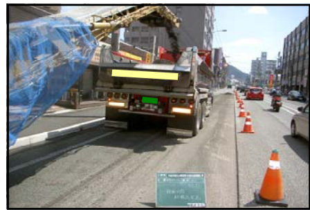
写真-5：昼間施工状況
