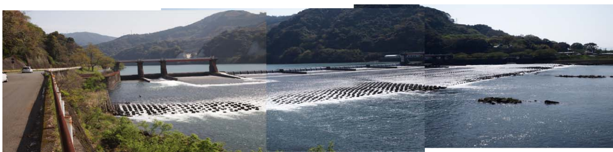
平成24年撮影 遙拝堰下流状況
