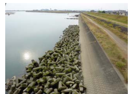
根固ブロック設置状況
