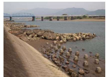
水制工設置状況
