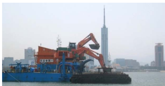
写真-2 施工状況
