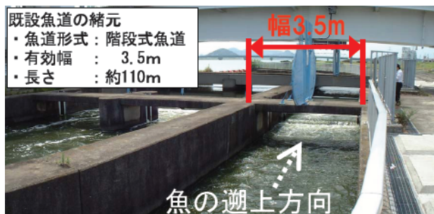
図-2 遠賀川河口堰の既設魚道
