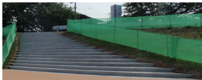
写真4 階段工（完成写真）
