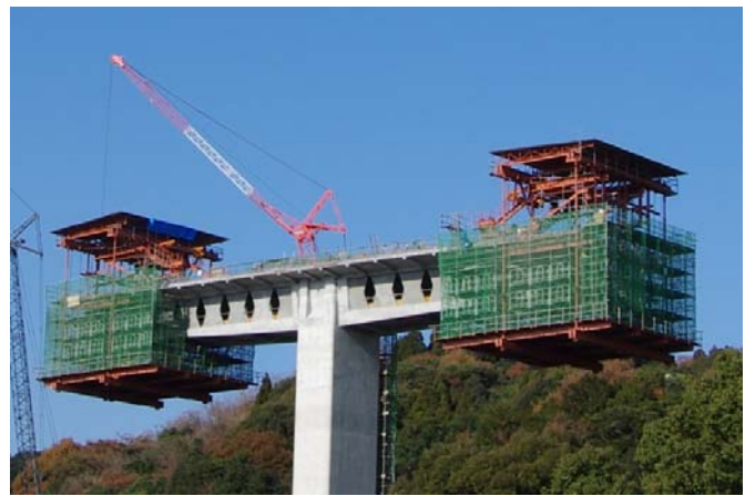
写真-2 張出し架設状況
