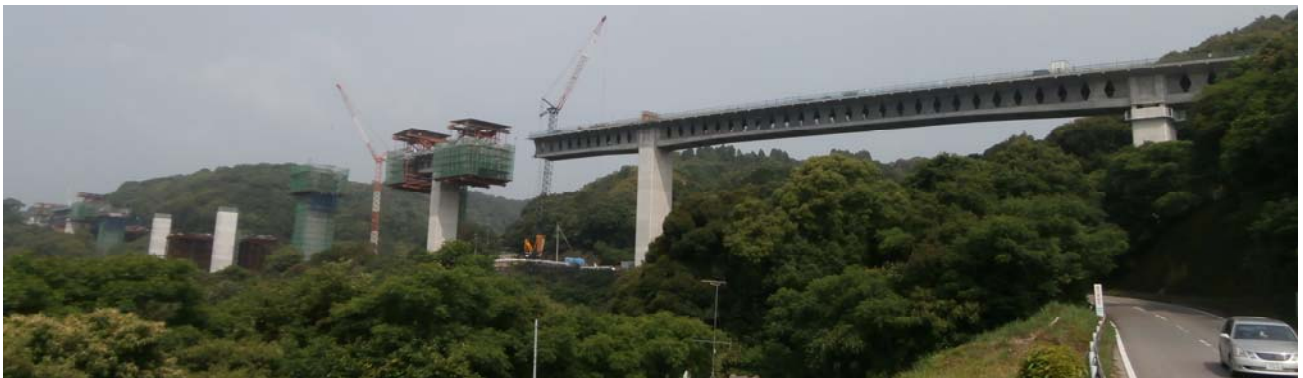
写真-3 全景 (平成 24 年 6 月中旬)
