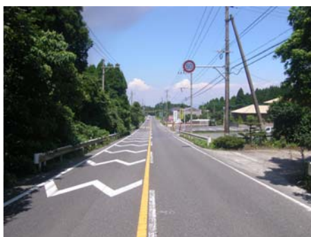
写真-1 工事着手前の状況
