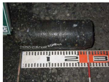
写真-3 ひび割れ部のコア（表面からのひび割れ）
