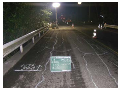
写真-2 路面切削後の損傷状況
