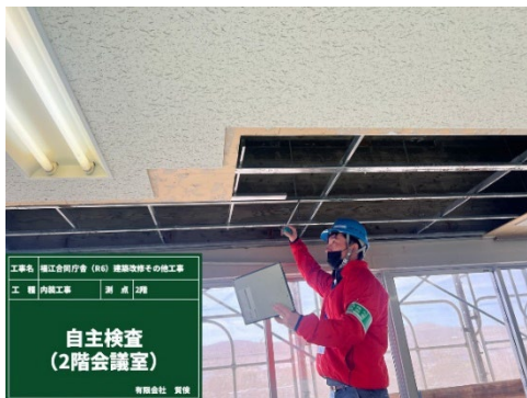
天井張替部分の自主検査
