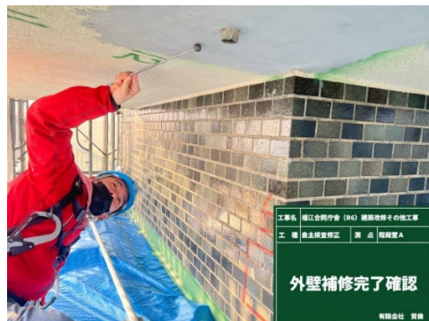
外壁部分の打診確認
