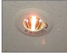
非常用照明器具
