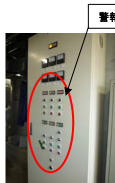
空調自動制御盤
