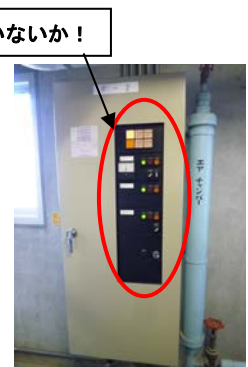
給水設備用制御盤
