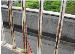
てすり子の腐食状況
