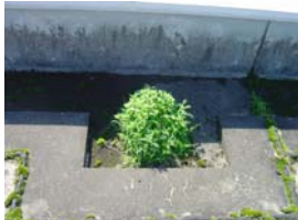
ルーフトレーンの詰まり
