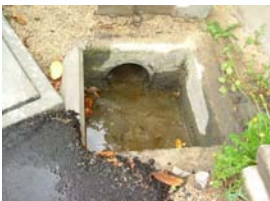
排水樹の泥溜り
