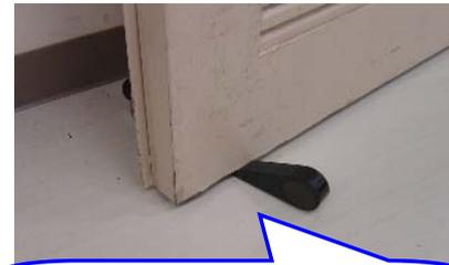
くさび等で開放状態にするとドアの変形により故障の原因となります。
