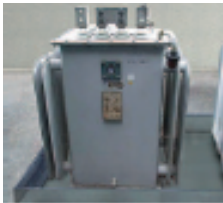
高圧トランス
