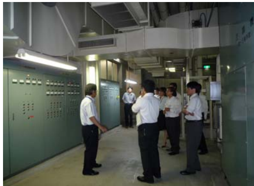
設備機器の説明
