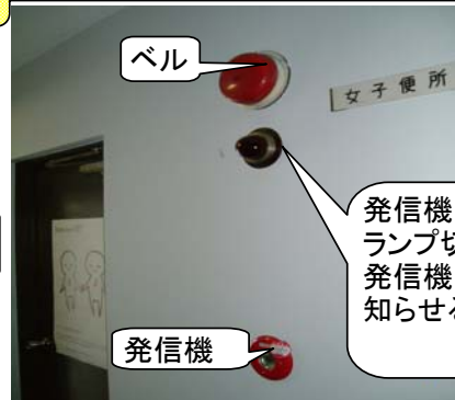
制御盤の表示灯 ランプ切れ
