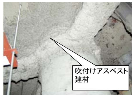
鉄骨耐火被覆
