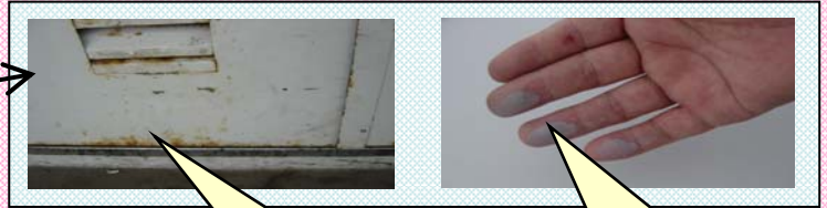
点さびが発生
