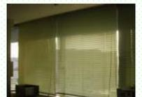
非空調時期においては、**スラット(羽根)の角度を調節**することで明るさを調節できますので、照明の明るさセンサーで照明制御をされている場合は**節電**をすることができます。**ブラインドをうまく使用して節電**してください。
