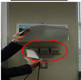
温度センサーがカレンダーで隠れていた。(事例)
