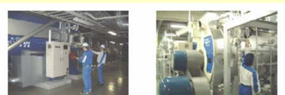
ボイラーの定期点検
